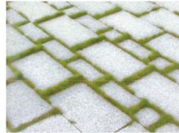
Dalles de granit avec joints ouverts
