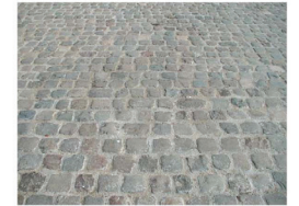
Pavés de granit à joints fermés
