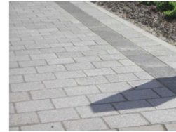
Dalle granit avec joints fermés
