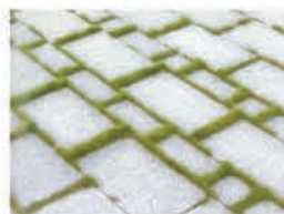
Dalles de granit avec joints ouverts
