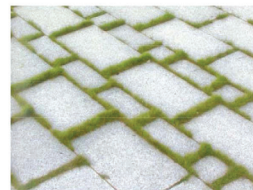
Dalles de granit avec joints ouverts
