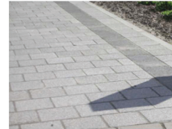
Dalle granit avec joints fermés
