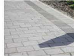
Dalle granit avec joints fermés
