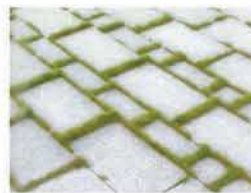
Dalles de granit avec joints ouverts
