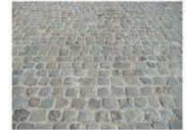
Pavés de granit à joints fermés
