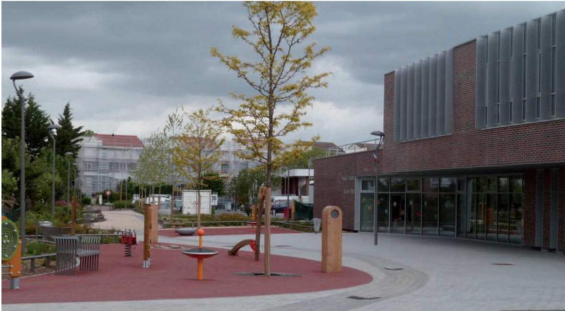
Parvis du groupe Scolaire J.Brel
