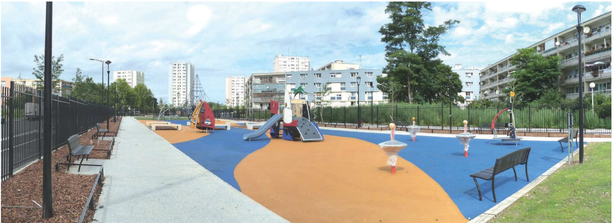
Chantier en cours
